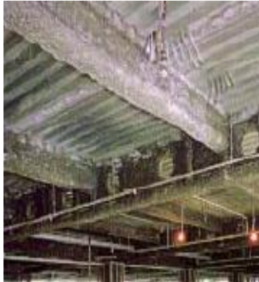
【耐火被覆材：柱・梁】
