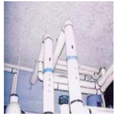
【吸音・断熱材：機械室壁・天井】
