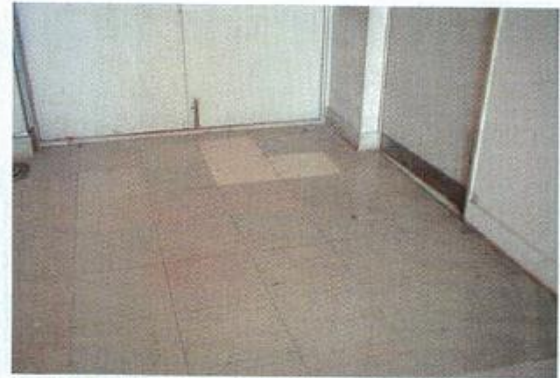
ビニール床タイル（石綿含有）
