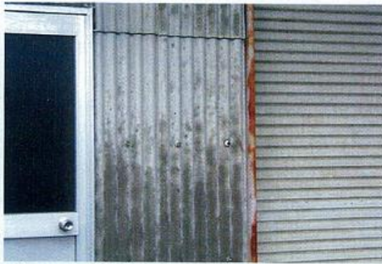
石綿スレート（波形）
